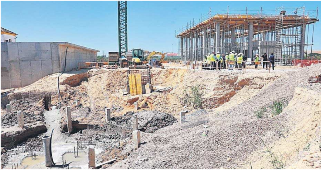
Obras de la estación depuradora de aguas residuales (EDAR) de Isla mayor en abril del año pasado.
